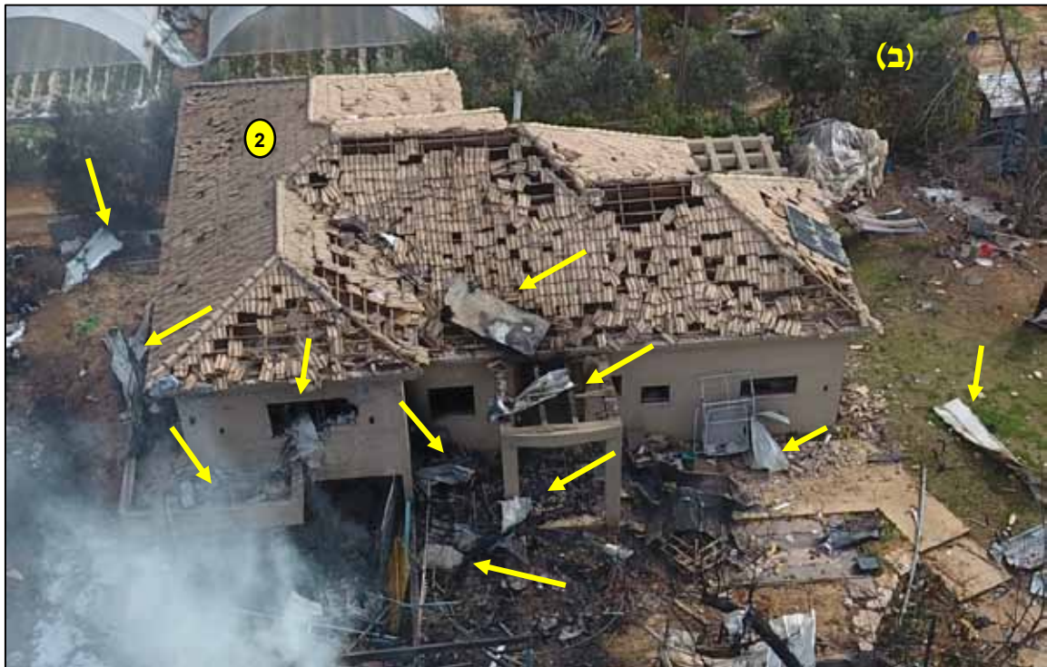
תמונה 9. פגיעות רסס בטווח המידי : (א) מבנה מגורים 1 – פיזור רסס ורגמות על המבנה ובסביבתו (ב) מבנה מגורים 2 - פגיעות רסיסים/רגמות וסימוני פגיעות בקירות ופתחי המבנה.
