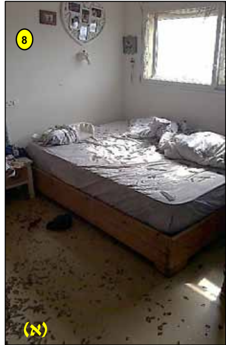
תמונה 8. פגיעות הדף במבנים (110 מ') - מבנה מגורים 5 : (א) שבר תריסים/משקופים, ניפוץ חלונות (ב) עקירת רעפים (ג)-(ד) נזקים מבניים בקירות/תקרות הבית
