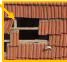
תמונה 8. פגיעות הדף במבנים (110 מ') - מבנה מגורים 5 : (א) שבר תריסים/משקופים, ניפוץ חלונות (ב) עקירת רעפים (ג)-(ד) נזקים מבניים בקירות/תקרות הבית
