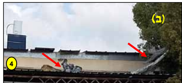
תמונה 10. פגיעות רסס ורגמות (דרום-מערב) : (א) מבנה 7 - עבודה ומשרדים - סימוני רגמות על הגג, רסיסים. (ב) רגמות מתכת בחלקו המערבי של מבנה 7. (ג)-(ד) מבנה מגורים 6 - רסס ורגמות על הגג ובחצר (שברי בלוקים).
