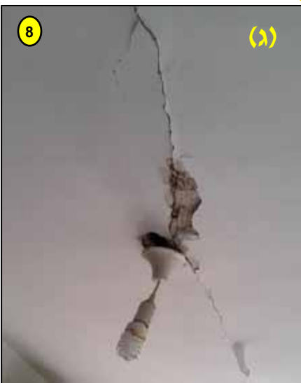
תמונה 8. פגיעות הדף במבנים (110 מ') - מבנה מגורים 5 : (א) שבר תריסים/משקופים, ניפוץ חלונות (ב) עקירת רעפים (ג)-(ד) נזקים מבניים בקירות/תקרות הבית
