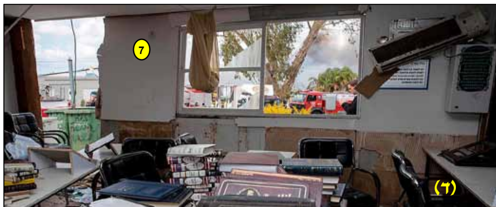
תמונה 7. פגיעות הדף במבנים (דרום מערב) : (א) מבט מבית הכנסת (מבנה 7) לכיוון מיקום האירוע (מבנה מגורים 1 מסומן בחץ אדום) ניתן לראות משמאל את משאית חברת "לביא אומגה". (ב)-(ד) פגיעות חיצוניות ופנימיות במבנה 7 - קירות, קריסת גג, ניפוץ חלונות.
